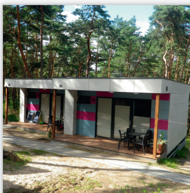
Technologia szkieletu drewnianego w systemie modułowym Moduły są zmontowane i wykończone „pod klucz” w zakładzie HATEK oraz dostarczane na wyznaczone przez klienta miejsce – ze stolarką okienną, instalacjami, z gotową elewacją i ścianami wewnętrznymi. Wyposażenie według wskazówek klienta (w oświetlenie, sprzęt AGD, meble łazienkowe i kuchenne). Zalety: szybki czas realizacji, wysoka izolacyjność cieplna i akustyczna, małe zużycie energii, atrakcyjne ceny.
