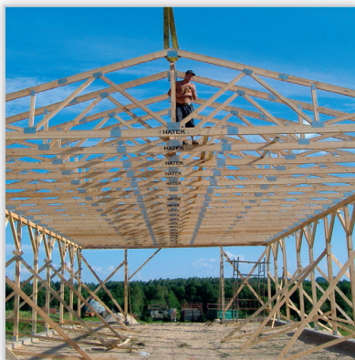
Budynek magazynowy w całości wykonany przez firmę HATEK Wymiary: 15/30 m. Wysokość użytkowa: 3,5 m.
