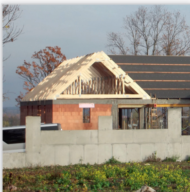
Wiązary dachowe z poddaszem na budynku mieszkalnym
